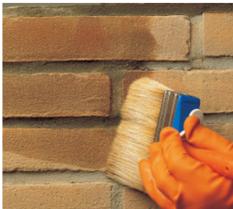
Εφαρμογή του Antipluviol S με βούρτσα
