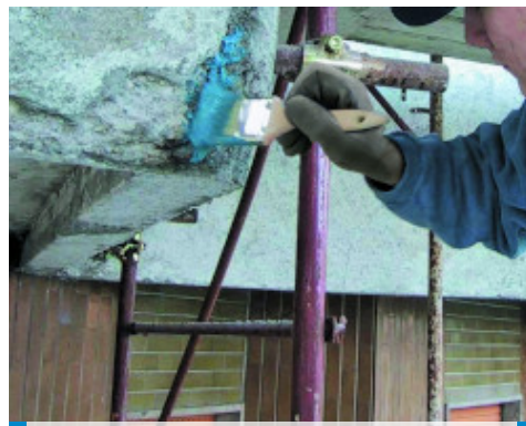
Εφαρμογή του Mapefer 1K με βούρτσα σε ράβδους οπλισμού μπαλκονιού από οπλισμένο σκυροδέμα
