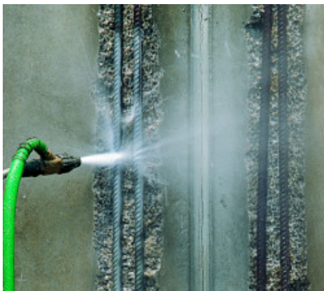
Καθαρισμός ράβδων οπλισμού
