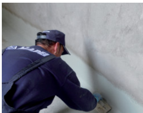
Εφαρμογή Mapelastic Foundation με σπάτουλα σε επέμβαση στεγάνωσης με αρνητική πίεση
