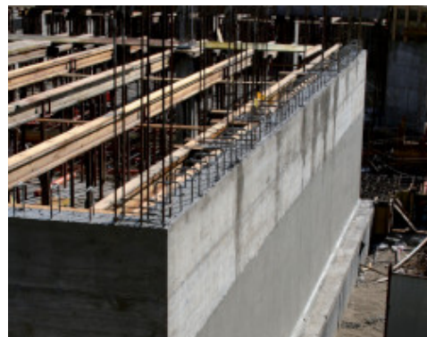
Τοίχος αντιστήριξης αδιαβροχοποιημένος μετά τη σκυροδέτηση με Mapelastic Foundation
