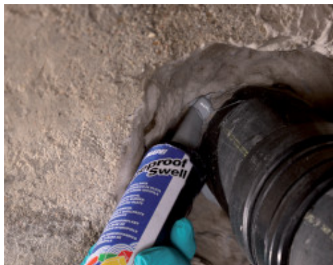
Διερχόμενο στοιχείο σφραγισμένο με Mapeproof Swell
