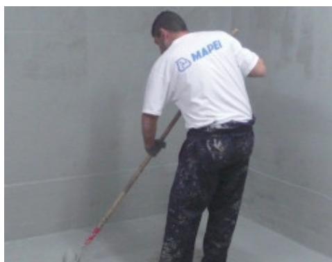
Εφαρμογή Mapelastic Foundation με ρολό σε επέμβαση στεγάνωσης με αρνητική πίεση
