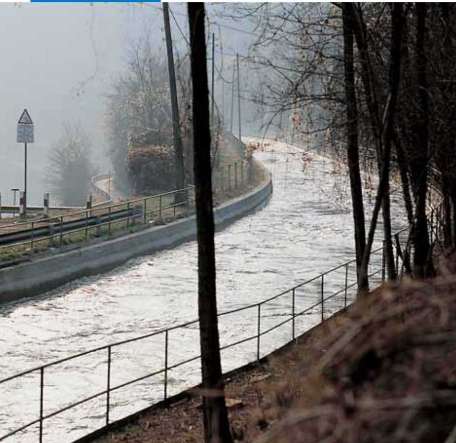
Υδροηλεκτρικό κανάλι Bertini κοντά στο Κόμο, Ιταλία. Επιφάνειες προστατευμένες με Idrosilex Pronto
