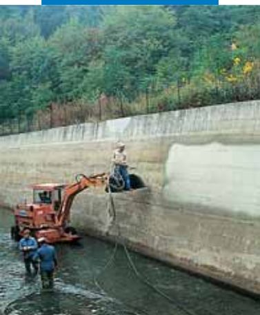
Εφαρμογή του Idrosilex Pronto με ψεκασμό σε υδροηλεκτρικό κανάλι
