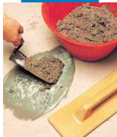
Γέμισμα φωλιάς: εφαρμογή κονιάματος
