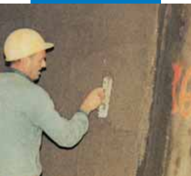
Τσιμεντοειδής σοβάς με Planicrete. Σήραγγα αυτοκινητόδρομου Ville Marie, Μόντρεαλ, Καναδάς
