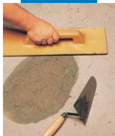
Γέμισμα φωλιάς: τελικό φινιρίσμα
