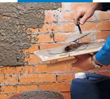
"Πεταχτή" στρώση σοβά ενισχυμένη με Planicrete
